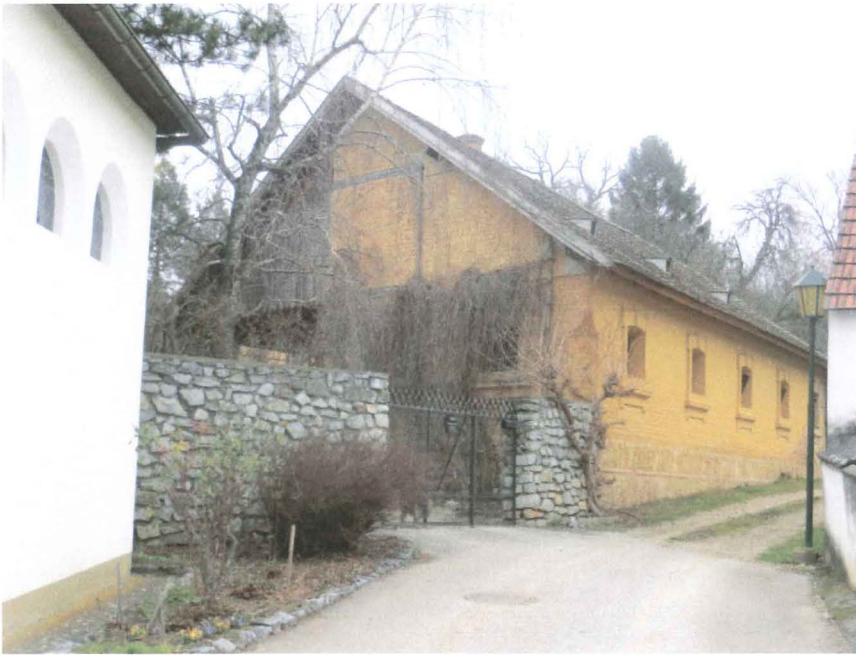
Leerstehende Baulichkeit im Anwesen des Dr. Gergely im Bauland - Agrargebiet
